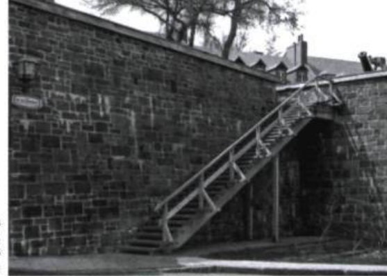
Escalier de bois de la Canoterie, de la côte Dambourgès à la rue des Remparts.
