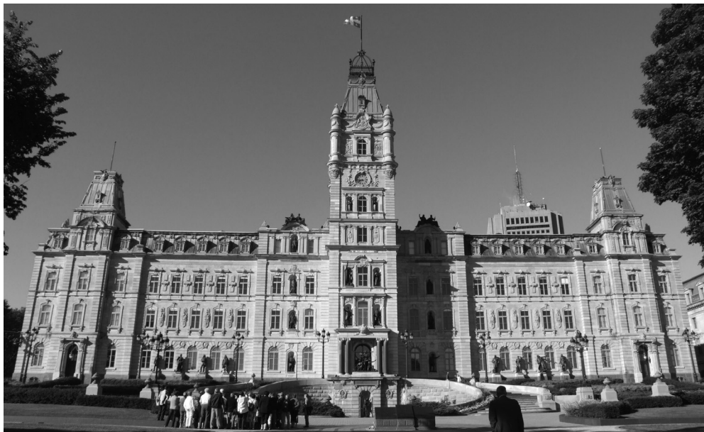
Fig. 11 La façade de l'Hôtel du Parlement à Québec, conçue par l'architecte Eugène-Étienne Taché, 1883-1886. © Photo : Assemblée nationale du Québec.
