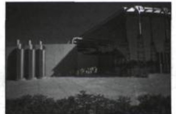
À gauche du Centre de préservation proprement dit, le bâtiment voué au chauffage, à la ventilation et la climatisation. (photo : BAC)
