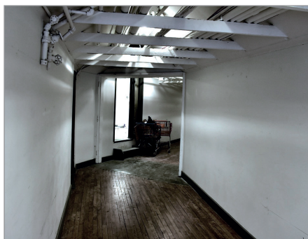
ILL. 12. COULOIRS À L'INTÉRIEUR DU BÂTIMENT. | LAURENT DAMBRE-SAUVAGE, 9 AVRIL 2018.
