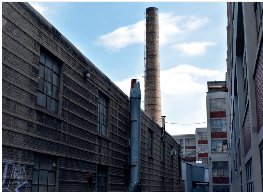
ILL. 5. BÂTIMENT RCA – VUE DE LA COUR SUR LA CHAUFFERIE ET LA CHEMINÉE. | LAURENT DAMBRE-SAUVAGE, 9 AVRIL 2018.
