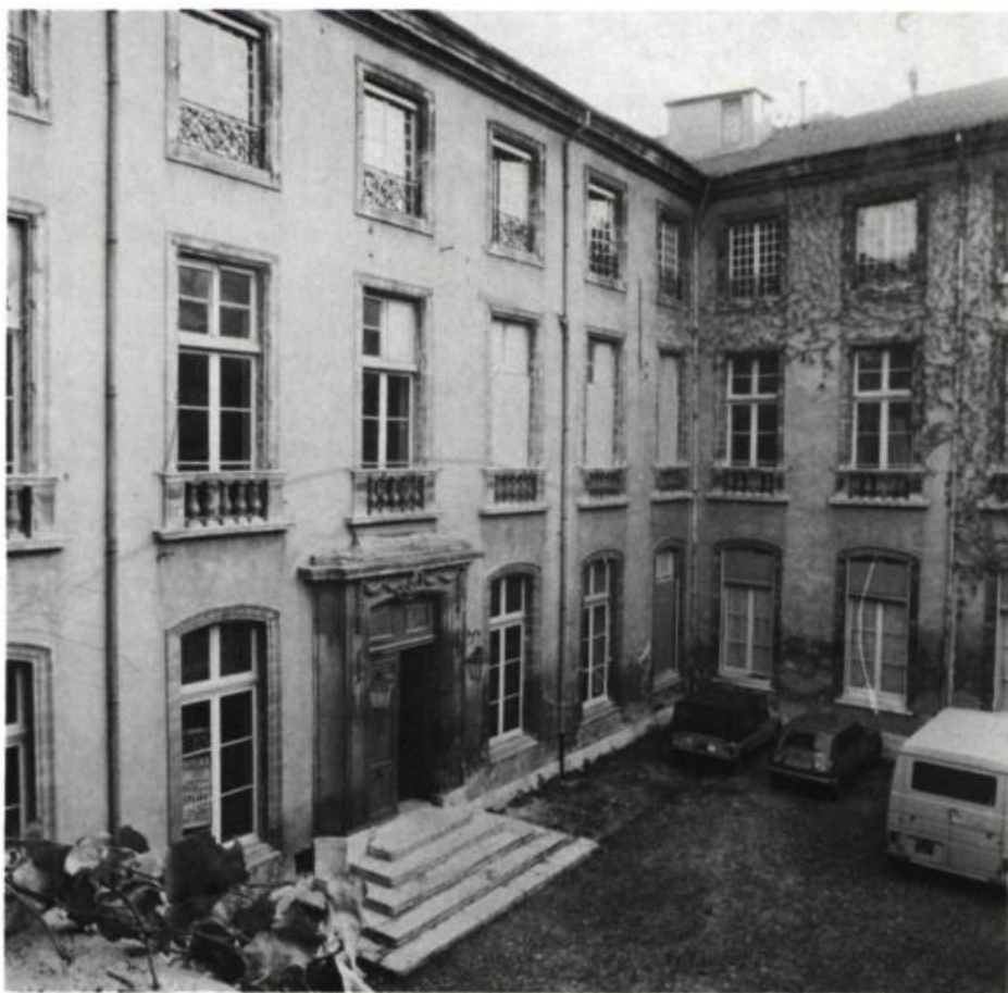
La Maison Jean Vilar. Cour et entrée du hall. Au premier étage se trouvent les salles d'exposition. Au deuxième, le centre de documentation et les magasins.
