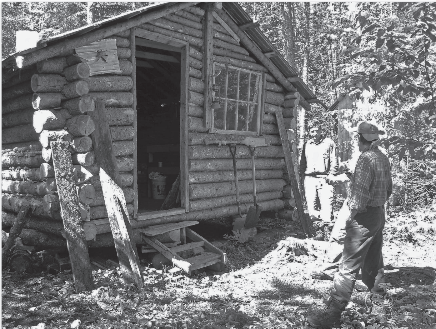
Les frères Tremblay expliquant les étapes de construction d'un tel type d'habitation. (Photo : Coll. IREPI, Huot-Tremblay, 2008)
