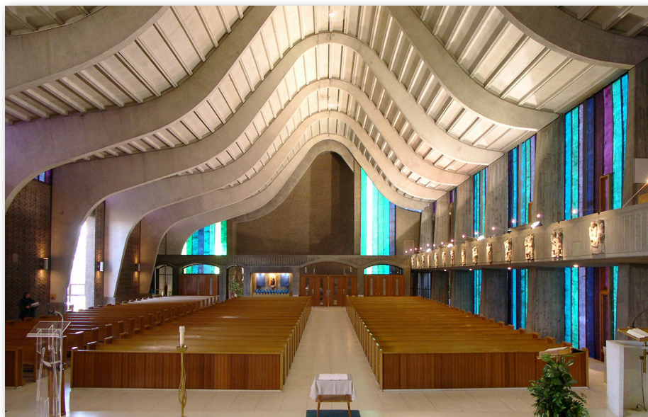
L'avenir de l'église Saint-Gérard-Majella à Saint-Jean-sur-Richelieu semble sans appel. Le peu d'intérêt suscité par ce bâtiment, pourtant reconnu comme une œuvre architecturale exceptionnelle, aura conduit à sa démolition, imminente. (Crédits photo : Conseil du patrimoine religieux du Québec, 2003)
