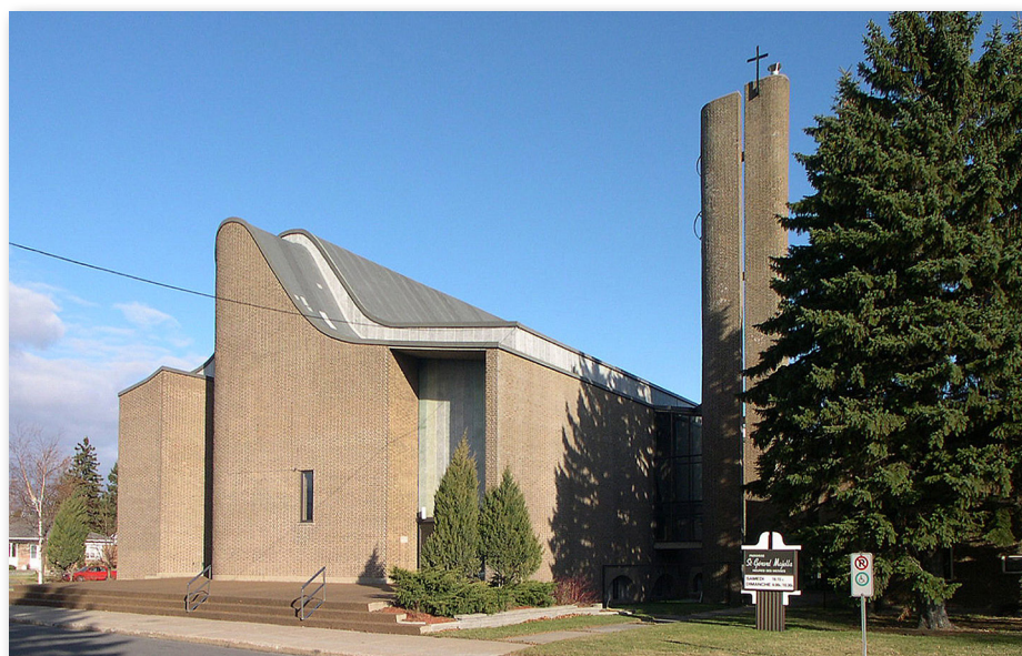
Église Saint-Gérard-Majella à Saint-Jean-sur-Richelieu qui sera démolie sous peu. (Crédits photo : Conseil du patrimoine religieux du Québec, 2003)
