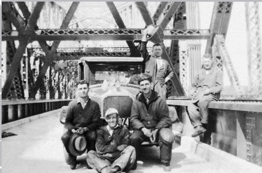
Ouverture de la première voie carrossable sur le pont de Québec, le 22 septembre 1929. (Photo : M me Hortense Plante)
