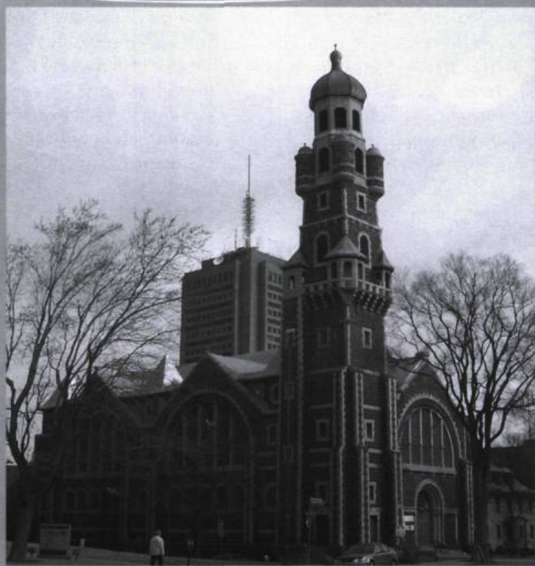
L'église Saint-Coeur-de-Marie, 530, Grande-Allée est, à Québec, fut construite dans un style architectural particulièrement original, le style romano-byzantin, qui évoque les premiers temps de la chrétienté et dont les voûtes de type Gustavino, notamment, font référence aux intérieurs des basiliques de la Rome Antique. À l'extérieur, le granite gris-rose, provenant de Rivière-à-Pierre, est également unique. Construite en 1919-1920, l'église fut ouverte au culte en 1921; la paroisse fut rattachée à la paroisse Saint-Dominique en 1986 et l'église vendue dix ans plus tard. Elle a connu certaines restaurations de sa tour en 1997, mais le reste tarde à venir. (Photo : R.M. Bégin, 2007)
