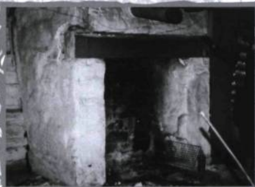
L'âtre de la maison McCarthy/Devlin. Les Irlandais maintiennent pendant la première génération d'occupation (1820-1840) la tradition d'ériger des âtres de pierre dans lesquels ils préparent les repas, alors que, durant la même période, les Québécois de souche utilisent les poêles à bois. (Source : Fonds Claude Bourguignon, collection privée)
