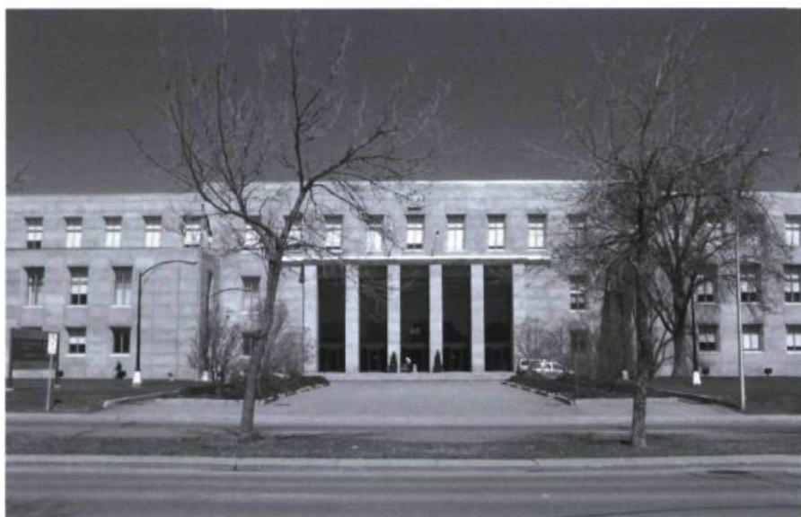
Illustration 4. Édifice de l'Imprimerie nationale du Canada, œuvre de l'architecte bien connu Ernest Cormier. Photo : R.M. Bégin.
