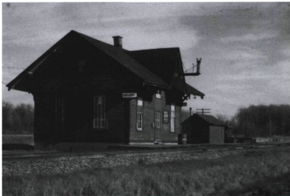
Les fonctionnaires ont fait détruite la gare. (Photo: Gilles Boileau)
