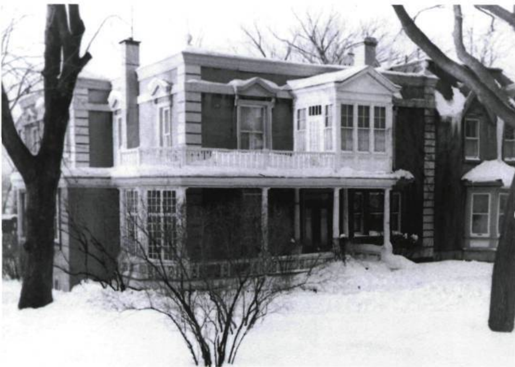
Maison bâtie pour la famille de Joseph Beaubien en 1905 et jumelée à celle de son père à droite, sur le chemin de la Côte-Sainte-Catherine. Les deux résidences furent démolies en 1960 pour faire place au parc Beaubien.
