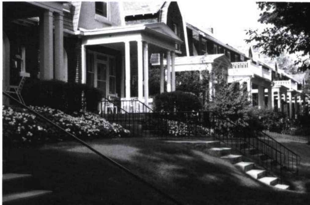
Rangée des maisons Beaubien de 1925 dessinées par les architectes Perrault & Gadbois dans l'avenue Stuart.
