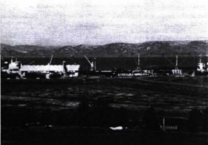
Une partie des installations du port de Gros-Cacouna.
