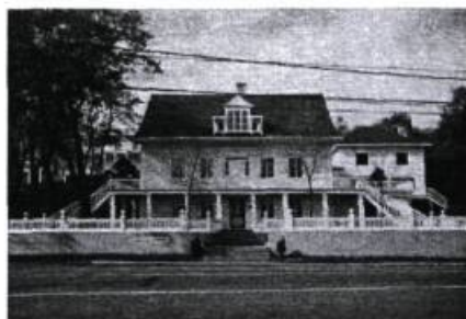
La Maison Chapais à Saint-Denis. PHOTO : Gilles Boileau.
