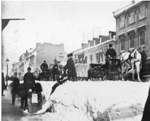
Figure 2 La neige « tapée » sur les rues
