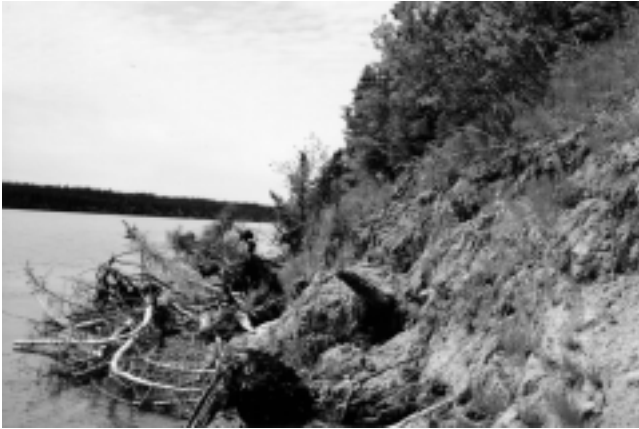
FIGURE 6. Sapement à la base d'une terrasse argileuse provoquant la chute de matériaux le long de la pente.
