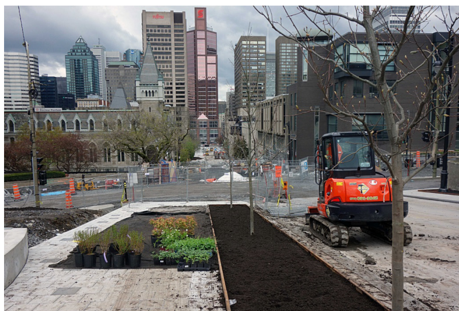
Figure 7. Étape de la promenade : les travaux dans la rue McTavish, mai 2017. (Source : H. Sturm).
