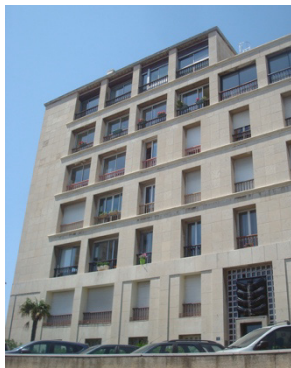
Figure 10 a . Façades austères de l'ensemble La Tourette.
