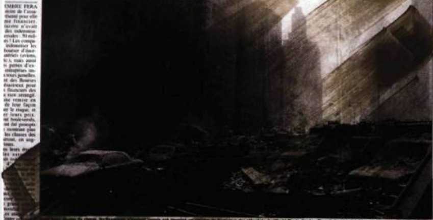
Après l'effondrement des tours, les débris du World Trade Center ont été rassemblés dans un immense tas de ferraille. En haut, des débris de la tour du World Trade Center, le 11 septembre 2001. Les débris du World Trade Center ont été rassemblés dans un immense tas de ferraille. En haut, des débris de la tour du World Trade Center, le 11 septembre 2001. Les débris du World Trade Center ont été rassemblés dans un immense tas de ferraille. En haut, des débris de la tour du World Trade Center, le 11 septembre 2001.
