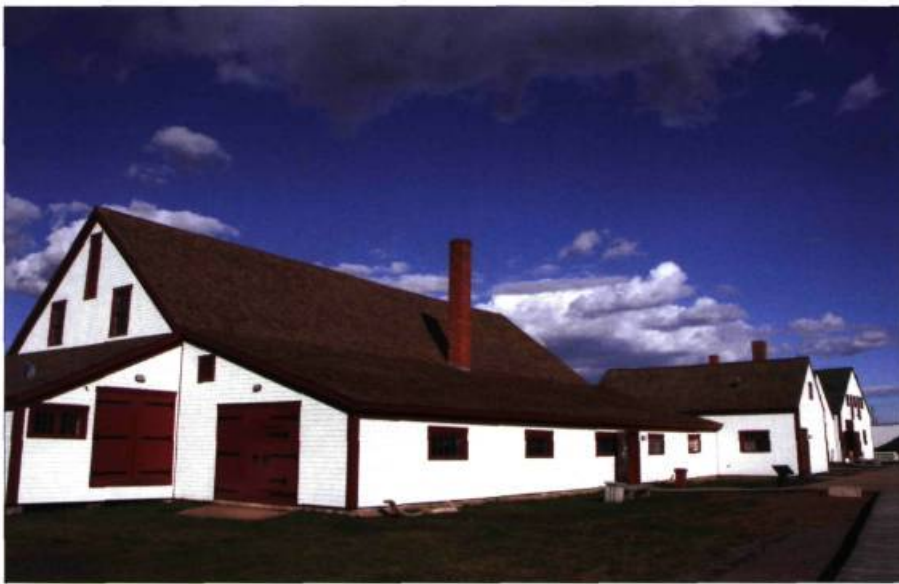
Un bâtiment qui compose l'ensemble du Banc-de-Pêche-de-Paspébiac.
