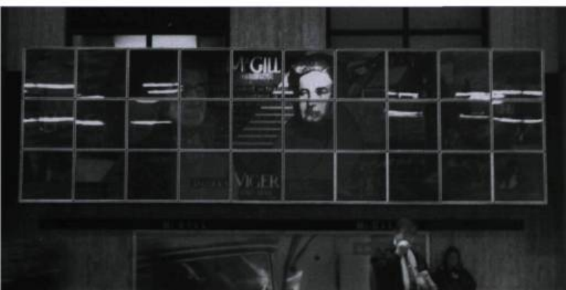
À la station McGill, les vitraux réalisés par Nicolas Sollogoub ont été soumis à l'expertise des restaurateurs afin d'améliorer l'éclairage. Les photos montrent une œuvre restaurée, et avant restauration.
