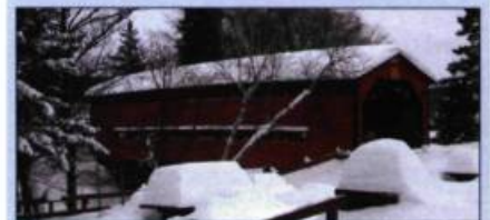
De ses 22,9 mètres de longueur, le pont couvert Saint-André enjambe fièrement la rivière Filkars. Bâti en 1927, il a été soigneusement préservé par les citoyens de Saint-Sylvestre.
