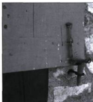
Il existe plusieurs façons de retenir les volets en place, que ce soit grâce à un esse pris ou au moyen d'une fiche et d'un anneau fixé dans la maçonnerie.
