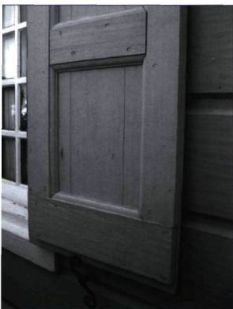
Il existe plusieurs façons de retenir les volets en place, que ce soit grâce à un esse pris ou au moyen d'une fiche et d'un anneau fixé dans la maçonnerie.
