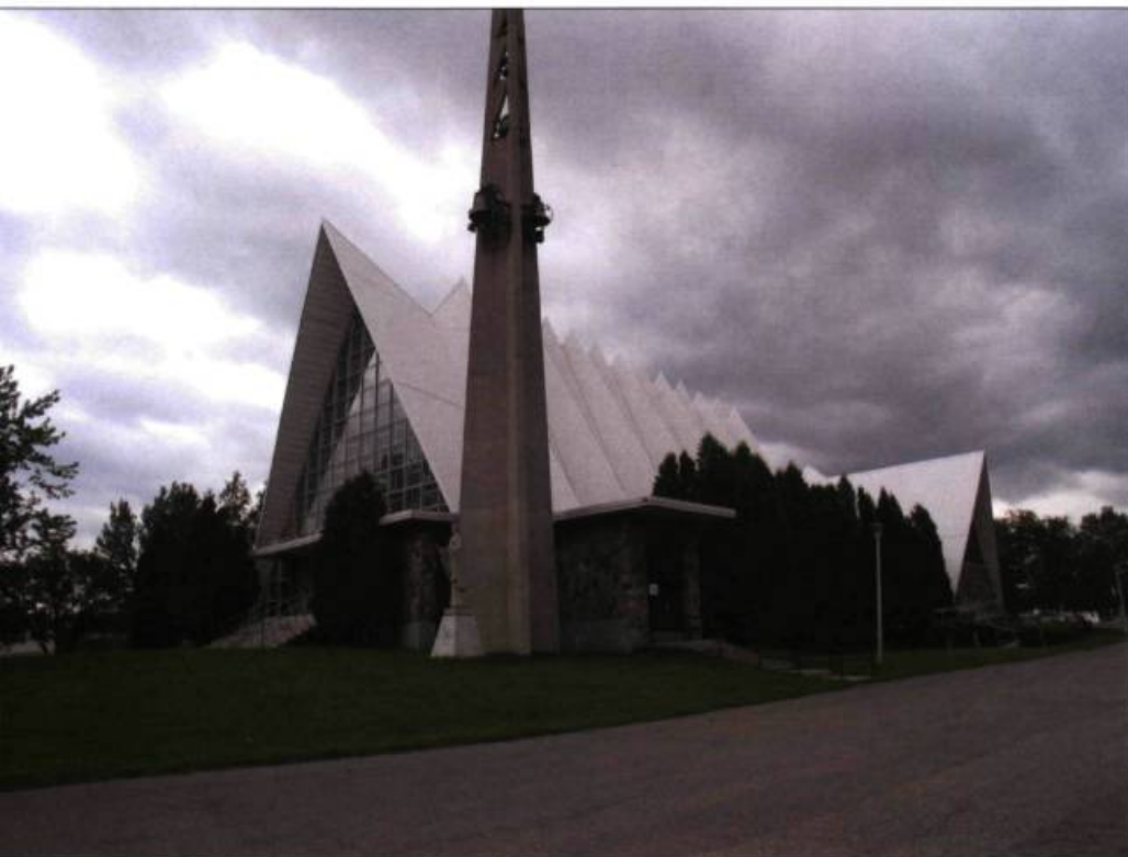
Surplombant la baie des Ha! Ha!, l'église Saint-Marc à La Baie a été construite en 1955-1956 par l'architecte Paul-Marie Côté. Son style annonce celui des églises modernes des années 1960. La toiture, une dalle de béton de 10 cm d'épaisseur, se plisse pour une résistance accrue.
