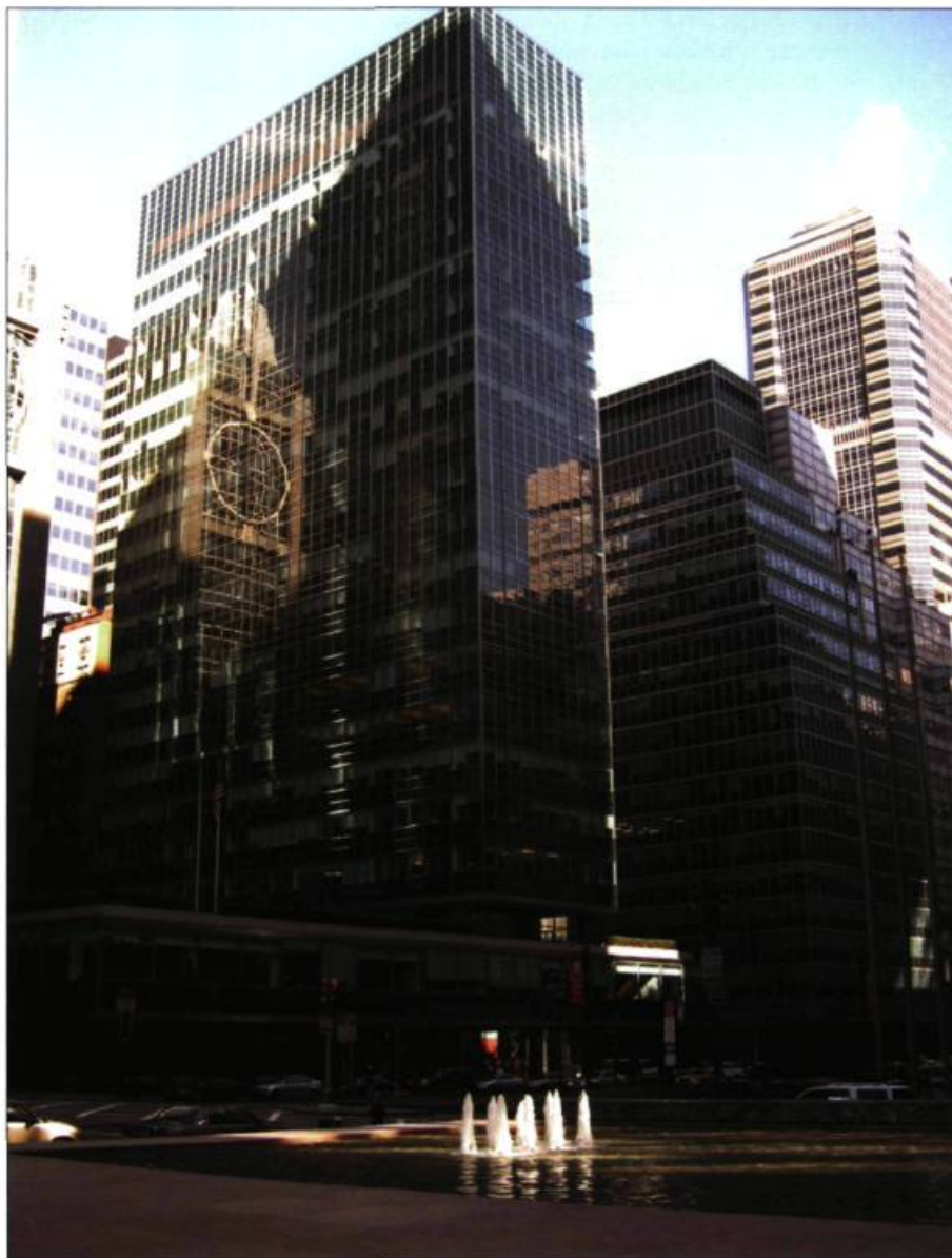
Le mur extérieur vert d'eau de la Lever House (1950-1952), située sur Park Avenue à New York, a fait l'objet d'une restauration exemplaire.
