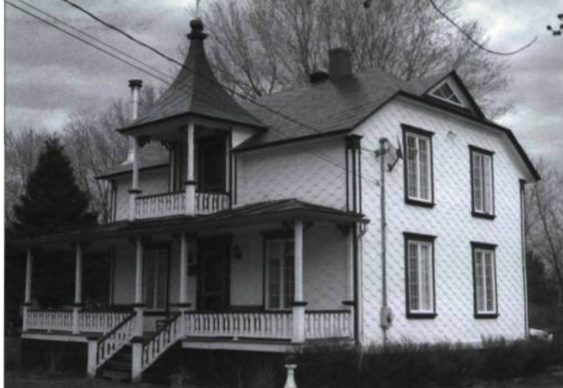
Le bardeau d'amiante est posé à la française, c'est-à-dire en diagonale de la gauche vers la droite.
