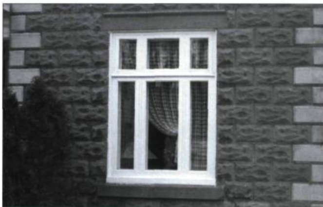
Le béton était souvent utilisé pour donner une apparence noble. On y imprimait des motifs imitant la pierre de taille et simulant la boucharde, les ciselures ou la taille à bossage.
