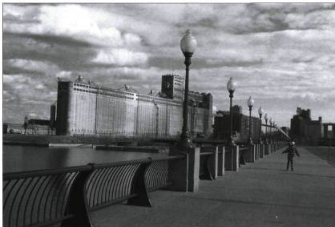
La pérennité et la mise en valeur du Silo n° 5, un des enjeux du développement du Havre de Montréal.
