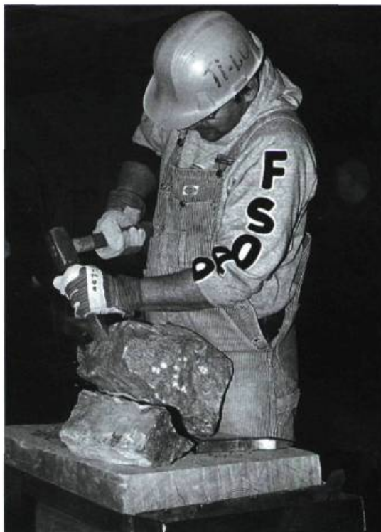
La taille de la pierre, une tâche en maçonnerie traditionnelle. Photo: Lester Toupin
