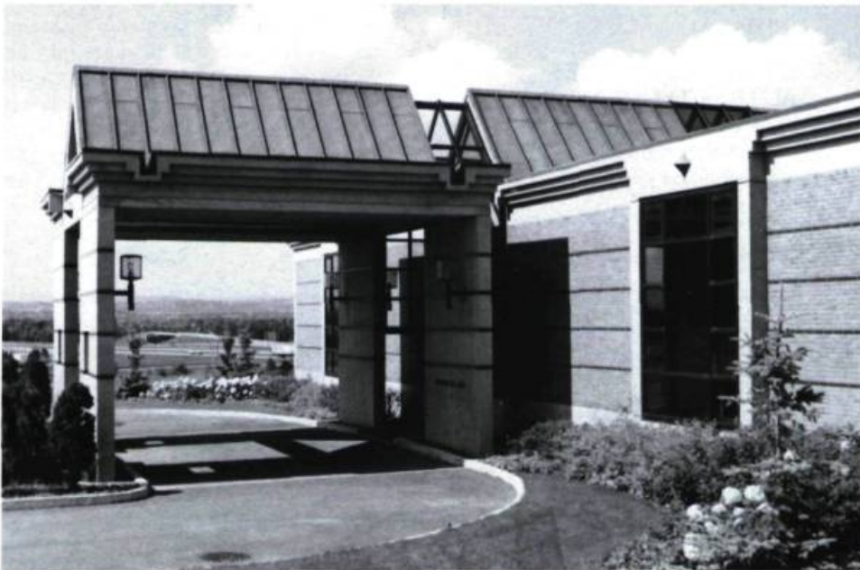
Une démonstration des plus probantes du post-modernisme: le mausolée du cimetière Belmont à Sainte-Foy, conçu en 1987 par les architectes Boutin et Ramois. (photo: Hélène Jobidon)
