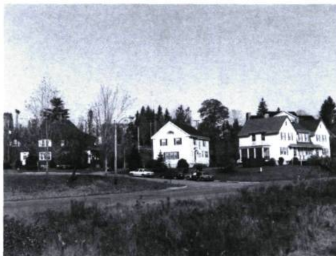
Lors de la démolition, en 1980, du pâté de maisons adjacent à l'usine, on a sauvé huit résidences qui ont été déménagées Place Consol. (photo: Jean Désy)
