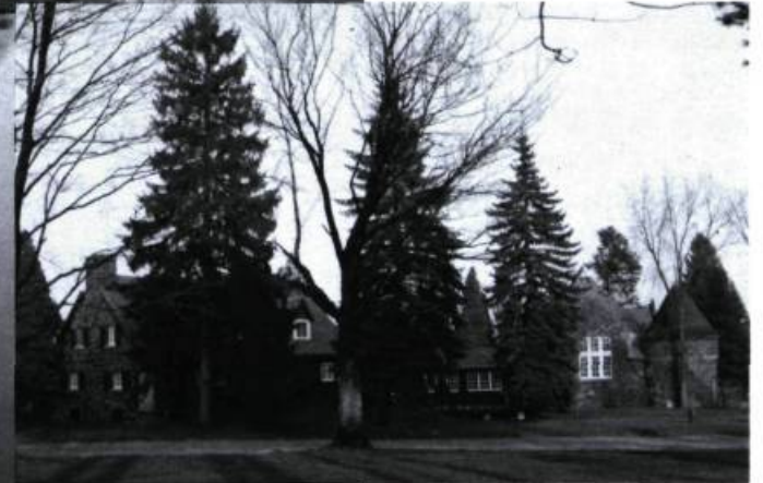
Le Centre de la culture de Grand-Mère occupe l'ancien Club Laurentide et le Community Hall construits par David Jerome Spence en 1912-1913. (photo: Jean Désy)
