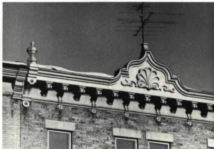
Dans le cas d'un bâtiment à toit plat, la corniche protège les parties sous-jacentes des intempéries et est souvent le seul élément ornemental de la façade. (photo: B. Ostiguy)
