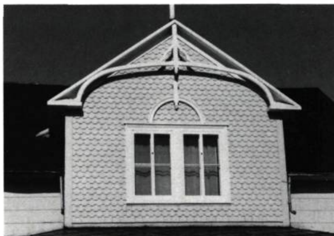
Le bardeau accroche et fait danser la lumière. Détail d'un fronton d'une maison résidentielle à Cap Saint-Ignace. (photo: F. Varin)
