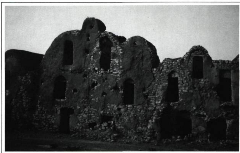
Habitations de terre et de pierre au ksar («lieu fortifié») de Debbab.
