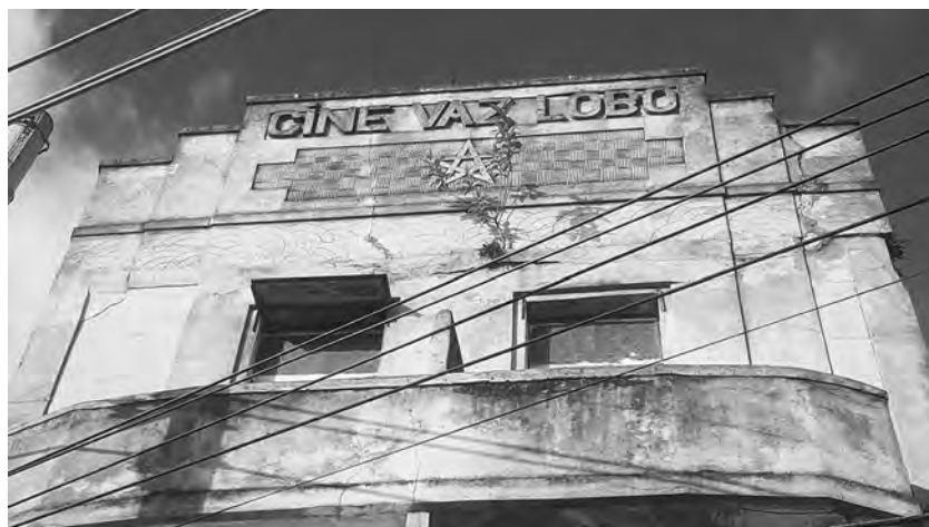
Figure 1. Façade du Cine Vaz Lobo, 2017. Photographie: Talitha Ferraz.
