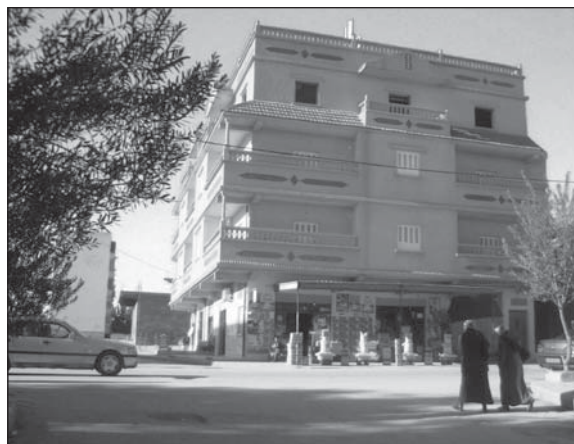
Figure 3 Construction à structure poteaux-poutres rassemblant commerces et habitat, à Aïn-Beïda
