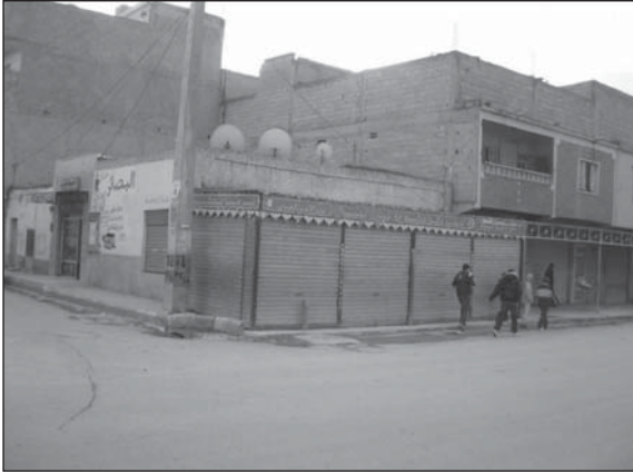
Figure 8c Annexion d'un morceau de trottoir pour l'extension d'un magasin à Aïn-Beïda (route de Khenchela)
