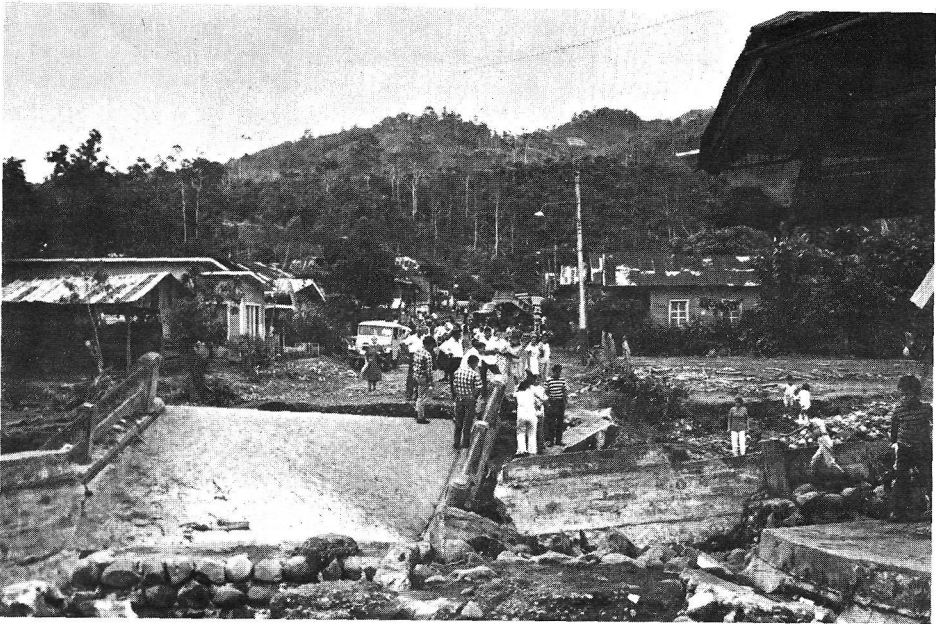
Photo 3 Village de la Suiza. L'érosion aiguë des berges explique l'affaissement de ce pont sur le torrent La Danta. Avril 1970.
