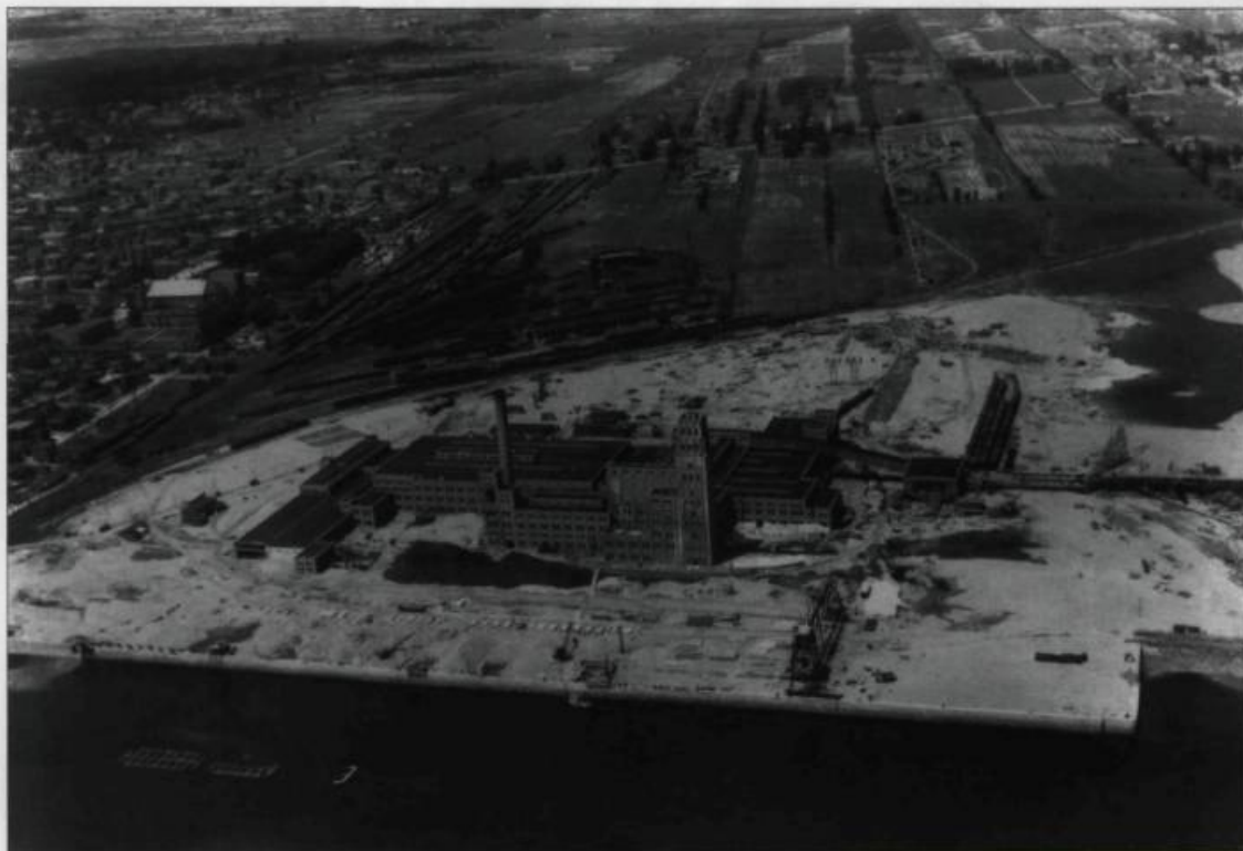
Vue aérienne du site occupé par la compagnie Anglo Canadian Pulp and Paper Company en 1929. (Archives de l'auteur).
