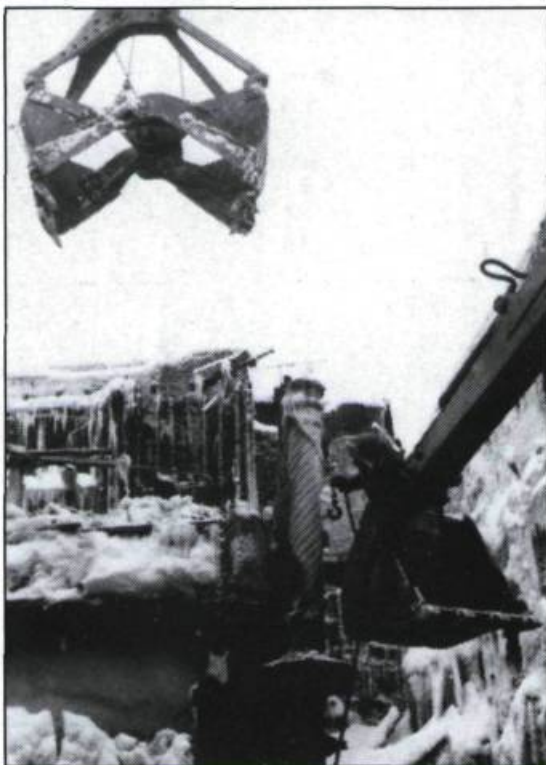
Après l'incendie de ce quadrilatère, un plan de sauvegarde fut mis de l'avant. Lors de la démolition des ruines, certains éléments architecturaux sont conservés puis intégrés à la nouvelle construction. (Photo: Service de l'urbanisme de la ville de Québec).
