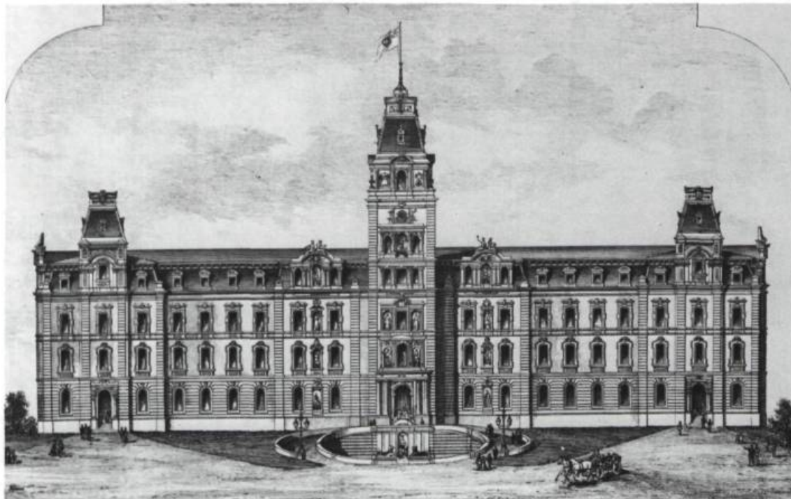
Façade des nouveaux édifices du Parlement à Québec. gravure de Eugène Haberer, vers 1880-1881. Photo: Archives nationales du Québec.
