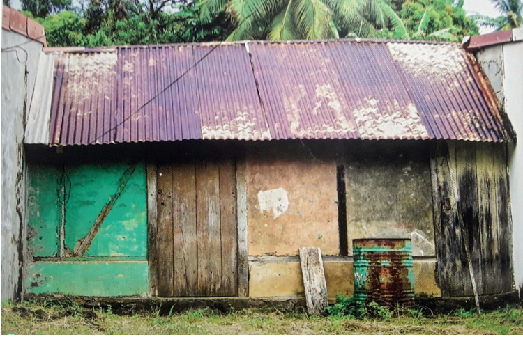
Une des dernières cases de travailleurs d'habitation de Desmarinières (Source : Exbrayat-op.cit.)
