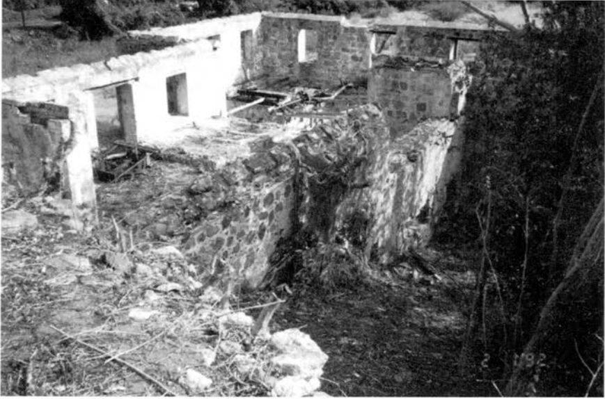
Fig. 13. – La partie la plus proche du bâtiment correspond à la sucrerie, avec ses foyers en contrebas, la partie du fond, à la purgerie-guildiverie. Dans la sucrerie on voit le mécanisme de la presse à coton ; dans la purgerie, l'arbre de transmission.
