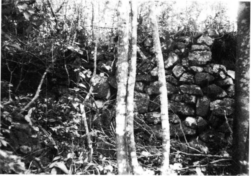
Fig. 17. – Muret de soutènement du moulin à bêtes à I niveau. Il s'agit d'un muret en gros blocs de pierres sèches.
