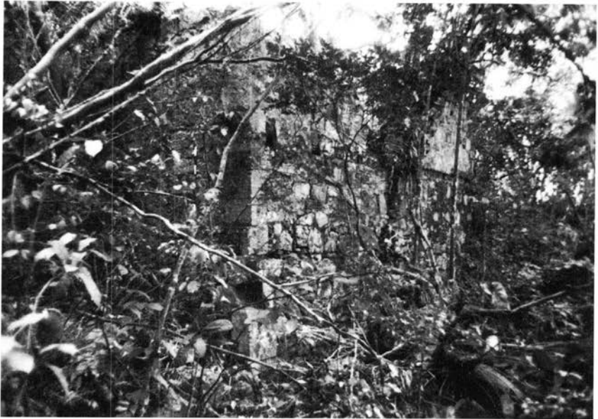
Fig. 18. – Le coin nord-est de la sucrerie-purgerie.
