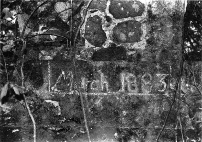
Fig. 4. - Date : mars 1883, gravée au-dessus des chaudières.
