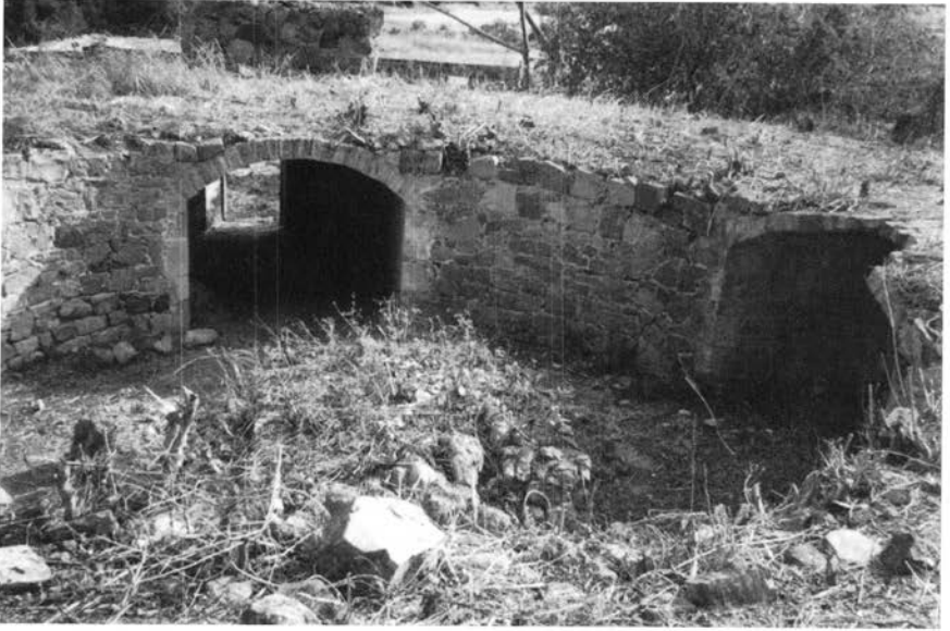
Fig. 11. – Le moulin à bêtes : la partie supérieure est destinée à la circulation des animaux. A l'étage inférieur : ce qui reste du socle du mécanisme.
