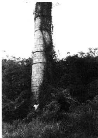
Fig. 6. – La cheminée en pierre de taille.
