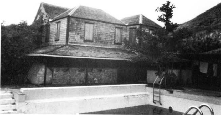
Fig. 22. – Façade ouest. Partie habitable en bois recouvert d'essentes, couverture en essentes.
