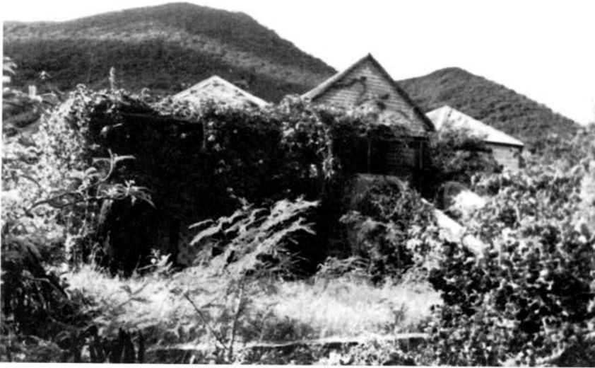
Fig. 21. – Façade nord. On devine l'escalier d'accès et le portique.
