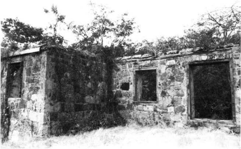
Fig. 14. – Appareil, chaînages d'angles, et huisseries de la purgerie et de la sucrerie.
