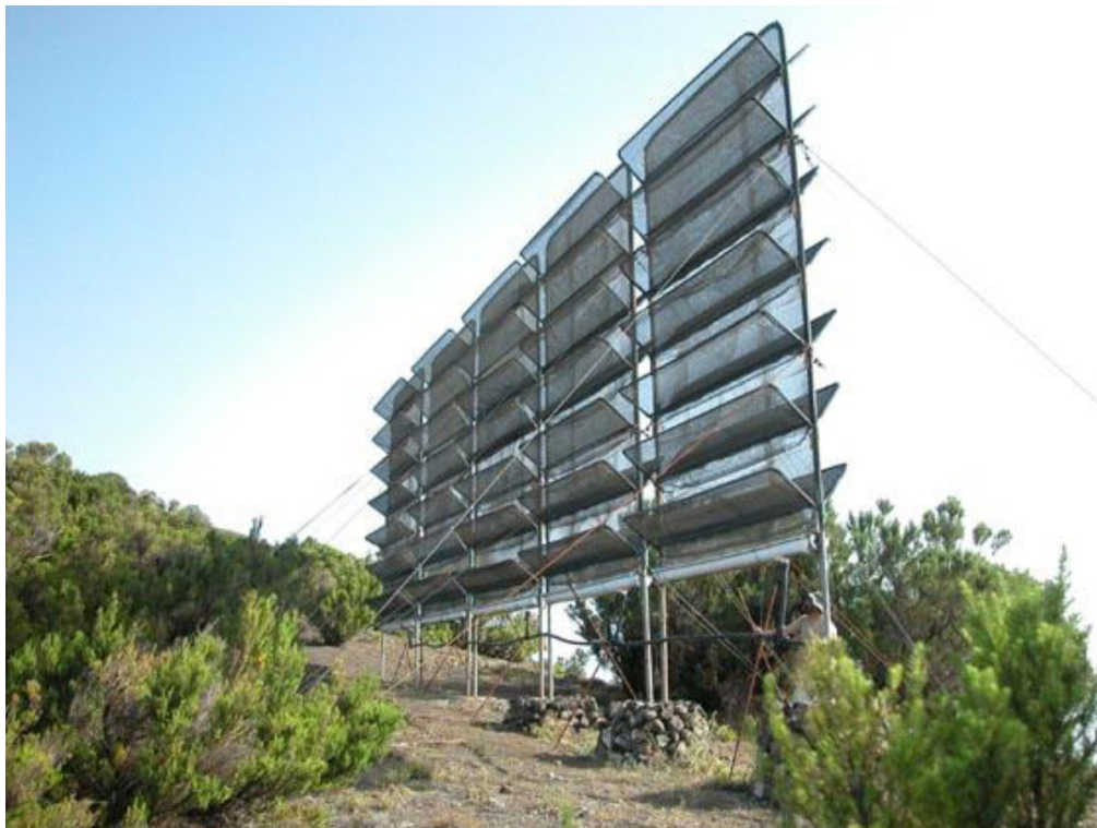
Figure 8. Des filets attrape-brouillard tels ceux installés au parc de Las Cancelitas à la fin de 2012. El Hierro, Cruz de los Humilladeros.
