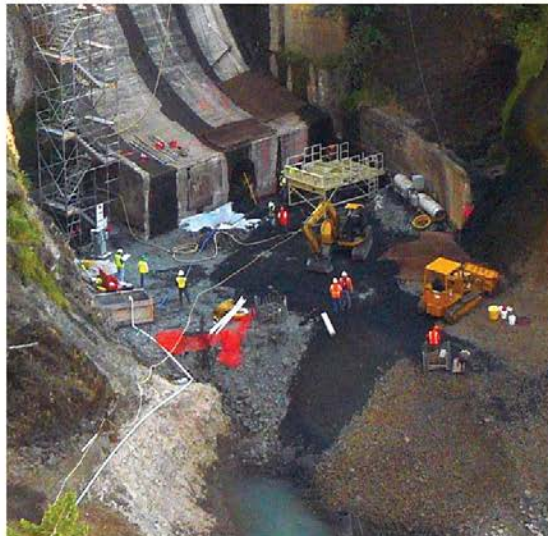
Démantèlement du barrage de Condit sur la White Salmon (ouest de l'Etat de Washington).
