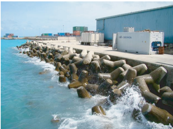
C. Cordons de tétrapodes qui protègent le port de Betio (Tarawa Sud, Kiribati) des risques liés à la mer (cliché : V. Duvat, 2010).
