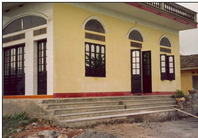
Figure 8. Exemple d'une nouvelle construction dans le quartier de Dong Thanh. Afin de lutter contre les inondations on surélève la maison d'environ un mètre. Photo : Éric Mottet, 2002.
