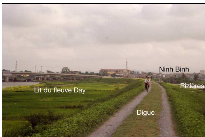
Figure 5. Les digues, système de protection et de communication. Leur hauteur fait qu'elles sont toujours surmontées d'une route ou d'un chemin, ce qui en fait un réseau de communications très efficace. Photo : Éric Mottet, 2002.
