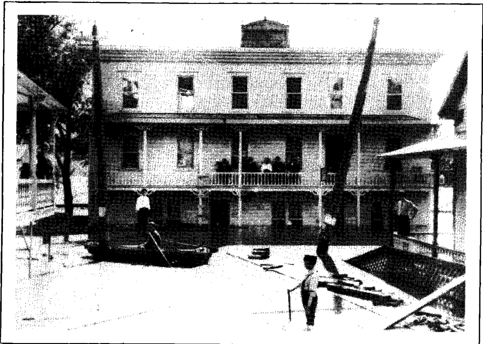
Débordement de la Chaudière. Photo tirée des Archives du Québec .
