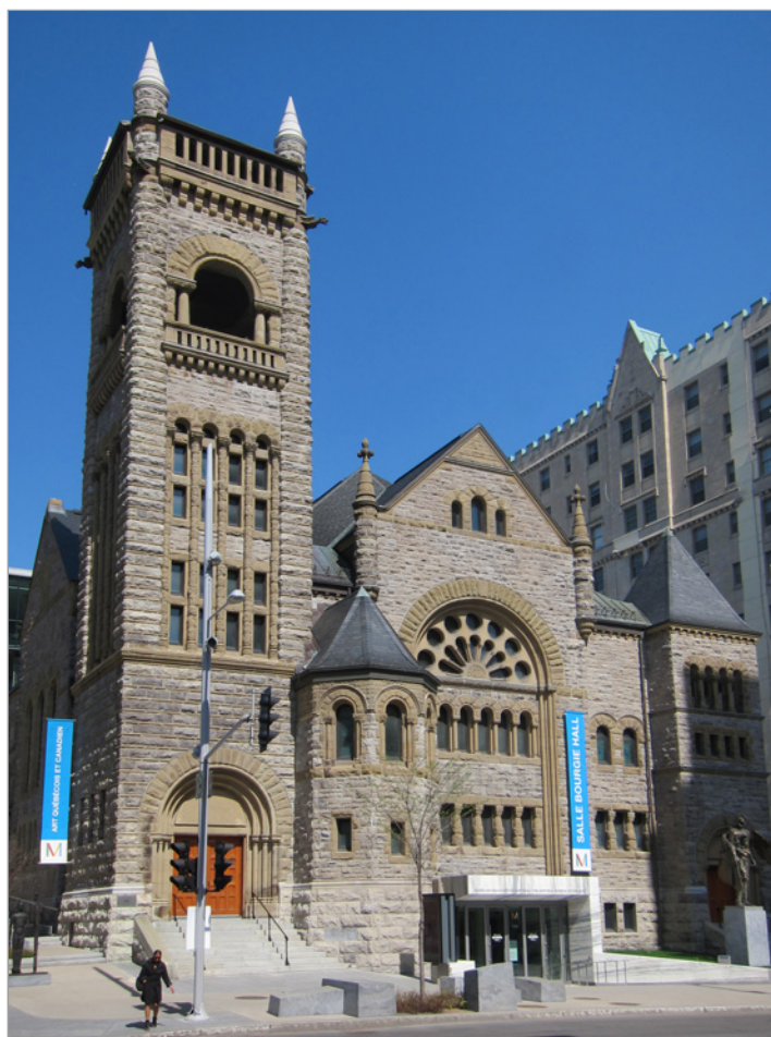
ILL. 7. SALLE BOURGIE AU MUSÉE DES BEAUX-ARTS DE MONTRÉAL (PROVENCHER ROY ET ASSOCIÉS, 2008) / ANCIENNE ÉGLISE ERSKINE AND AMERICAN UNITED (ALEXANDER COWPER HUTCHISON, 1893-1894). | © MARC GRIGNON.
