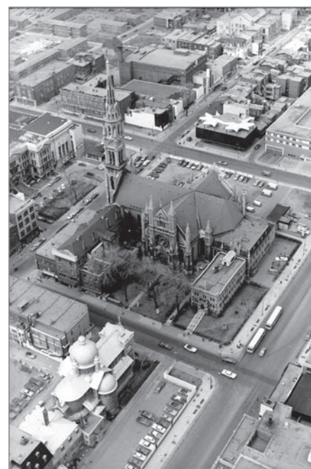
ILL. 17. VUE AÉRIENNE DU TRANSEPT SUD DE L'ÉGLISE SAINT-JACQUES, RUE SAINTE-CATHERINE (V. 1972). | ARCHIVES UQAM. FONDS D'ARCHIVES DU SERVICE DES COMMUNICATIONS, 45U-412.F3:02/6 (3 DE 4).
