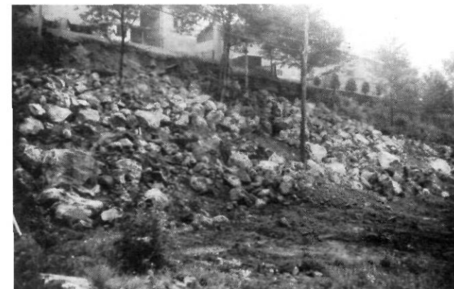
FIGURE 6B. Blocs provenant du till érodé par les eaux de l'exutoire du Kipawa à Témiscaming. Cliché 203990-P, Commission géologique du Canada.
