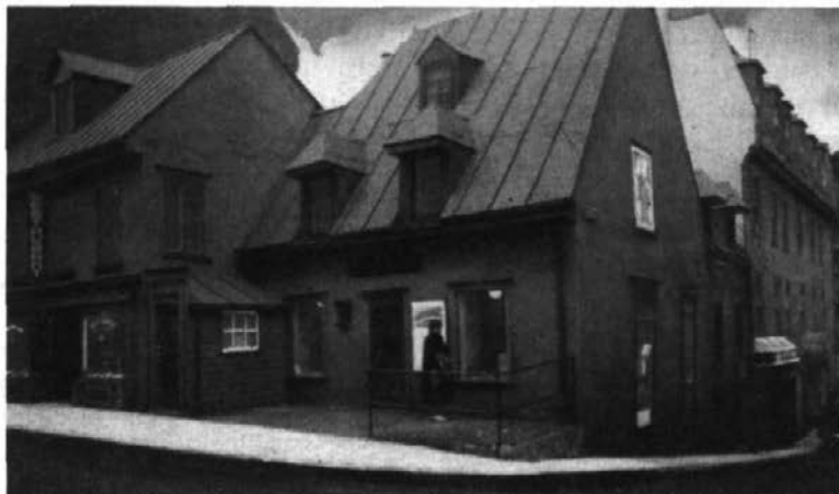
Maison Jacquet, dite « Maison des Anciens Canadiens » rue Saint-Louis à Québec. Elle a appartenu aux Lanaudière, à Gaspé pendant deux ans, à William Miller, puis de nouveau aux Lanaudière.
